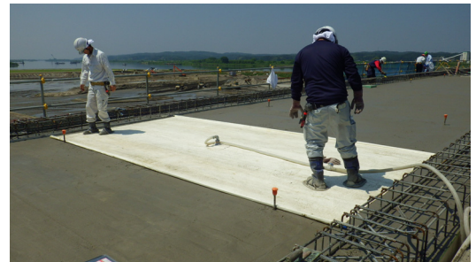
写真-1 真空脱水工法
