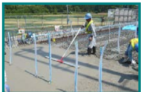
②コンクリート均し
