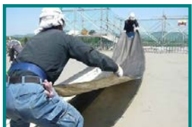
④BFろ過マット敷設
